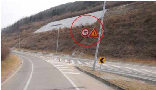
(c) 우회전 금지 표지 설치
