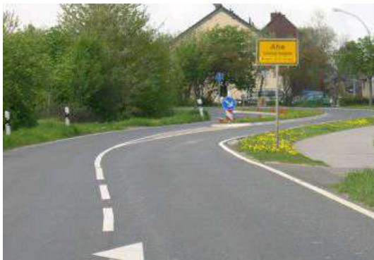
<그림 7-18> 지그재그 형태의 도로와 차로 폭 좁힘을 통한 자동차 주행속도 관리
