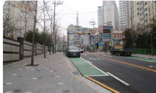
(b) 차도폭 좁힘 및 노상주차장 설치 사례
